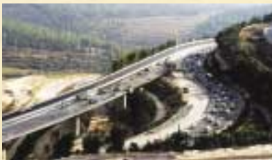
כביש 9 - מבט לגשר
